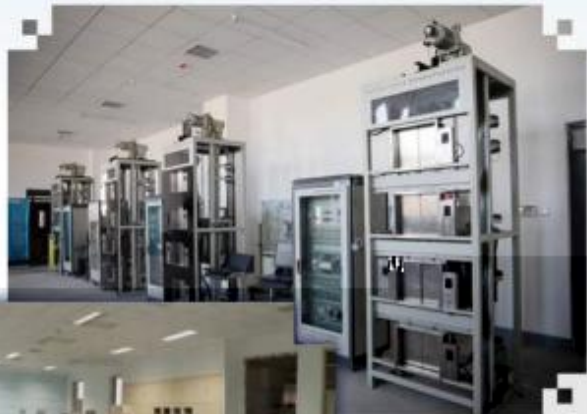
智能电梯安装调试维护训练场所
